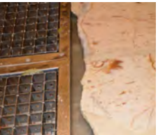
Разрушение пола при прилегании к трапу
