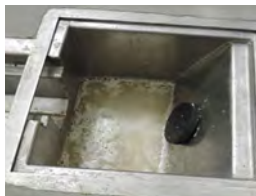
Застойная зона у трапа с горизонтальным выпуском
