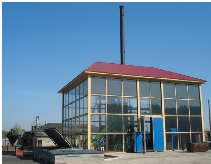
Рис.1. Общий вид промышленной установки с топливным складом
