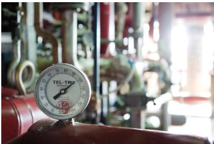
Цех переработки масел (ЦПРМ) был введен в эксплуатацию в конце 2011 года. Он включает линии рафинации, дезодорации, гидрогенизации, отбели, фракционирования и т. д.
