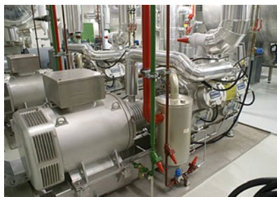
Промышленная установка на базе NH_3 и CO_2
