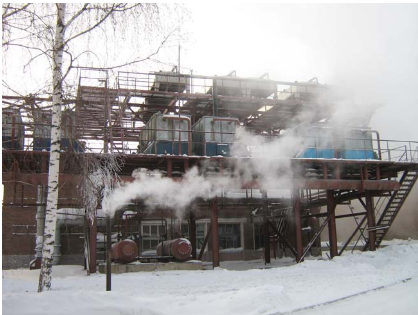
Система фрикулинга позволяет сократить время работы компрессора, сделав холодильную систему более энергоэффективной
