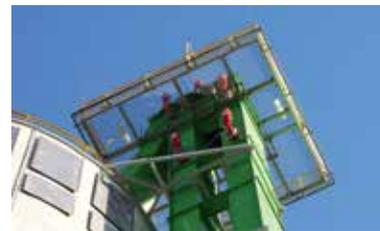
HRD система для активного подавления взрыва в нории и мембраны для снятия избыточного давления взрыва.
