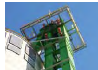
HRD система для активного подавления взрыва в нории и мембраны для снятия избыточного давления взрыва.
