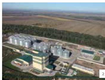
1. Комбикормовый завод 30 т/ч и зернохранилище 30 000 т 2. Комбикормовый завод 30 т/ч и зернохранилище 78 000 т
