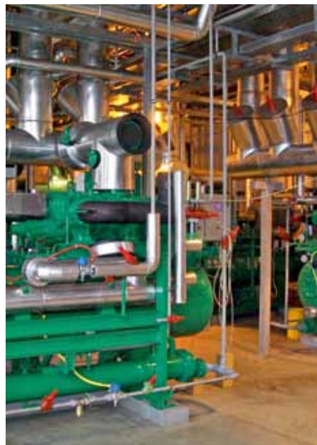
Компрессорные агрегаты «компаунд» МУСОМ
