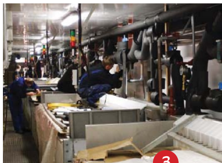
3/ Во время модернизации была заменена и заново изолирована система холодильных трубопроводов.
