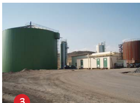
3/ Биогазовый комплекс по переработке куриного помета в биогаз и удобрения (электрическая мощность – 800 кВт)
