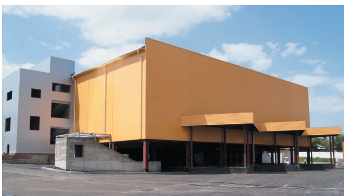
Строительство нового склада обеспечит возможность полной реорганизации логистики предприятия.
