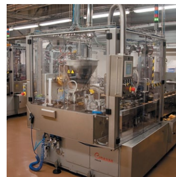
Фактически завод в Ершово стал первой собственной производственной площадкой финской компании Valio в России.
