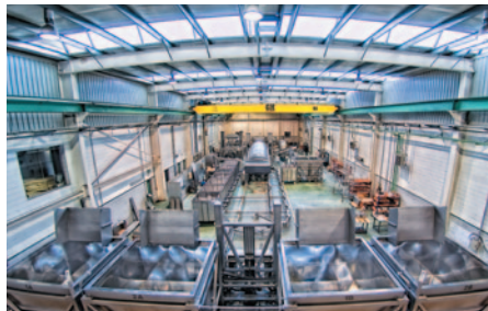
AUTOLINE: процесс монтажа линии TWINLINE & COOKLINE в цехе MQ
